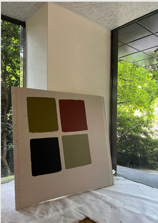
Androne della torre Orione 2 durante la fase di gessatura e rasatura dei muri.
