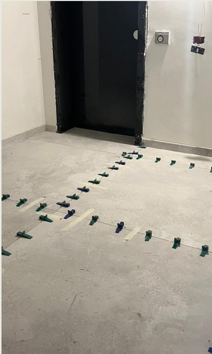
Androne della torre Orione 2 durante la fase di posa delle piastrelle
